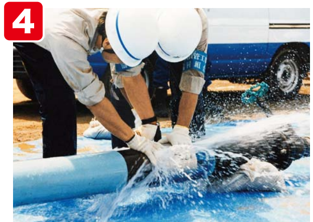
4 破損箇所がクランプの中心にくるようにセットします。
