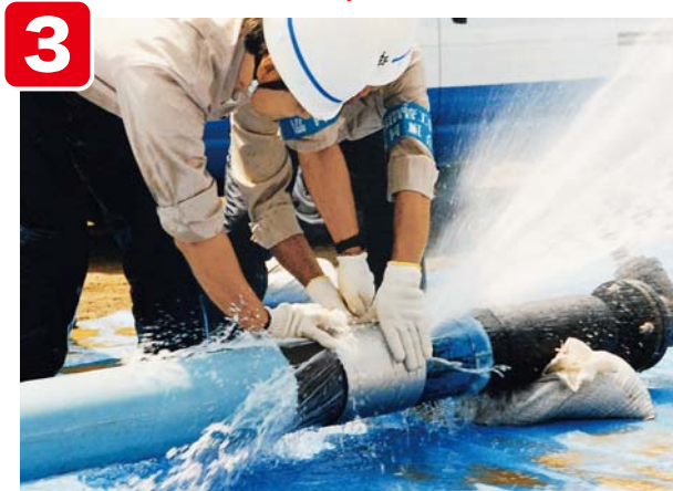
3 漏水箇所に素早くずらします。
