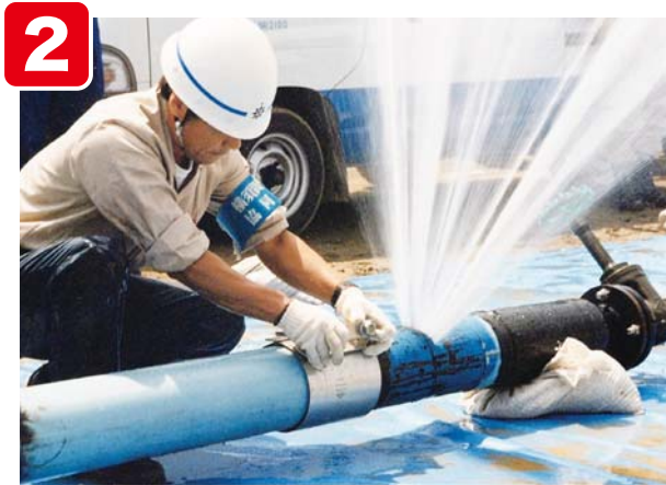
2 修理用クランプを漏水箇所のすぐ横にセット。
