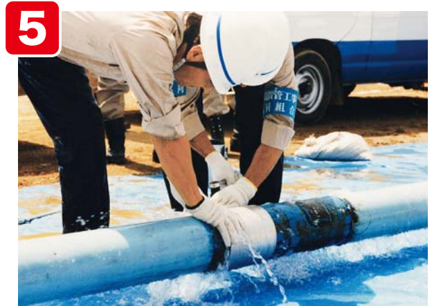
5 適正トルクで締め付けます。
