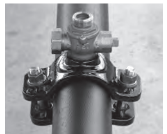
穿孔が完了した状態
