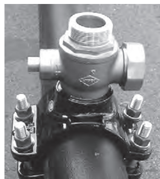
穿孔が完了した状態
