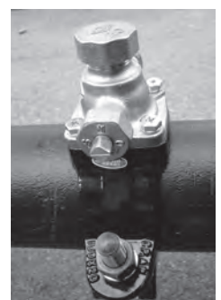
挿入が完了した状態
