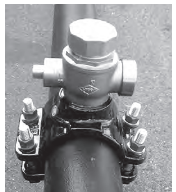
挿入が完了した状態
