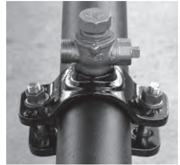
挿入が完了した状態
