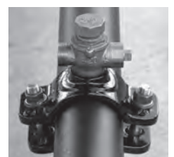
挿入が完了した状態
